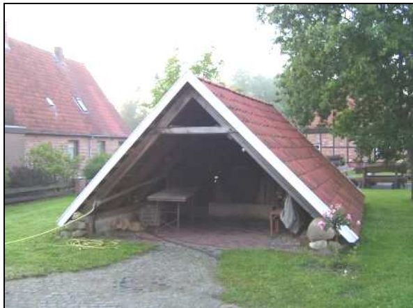
Dachgerüst zur Aufnahme des Backofens
