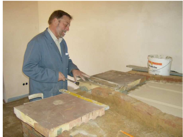
Wolfgang besorgte die Schamottplatten und half bei dem Einpassen.
