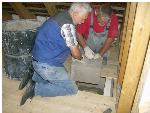
Der Schornstein wird durch die Decke geführt
