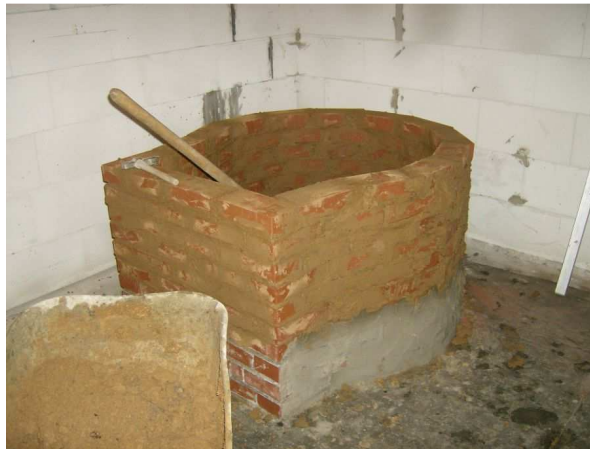
Der Innenkern ist auf Höhe gemauert und wird später mit Lehm und Quarzsand befüllt
