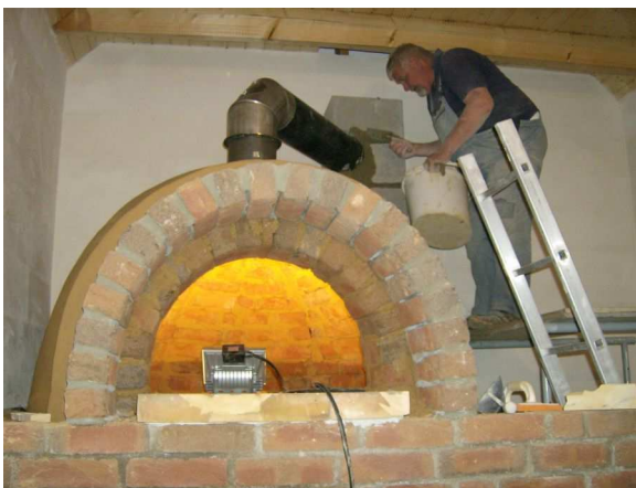
Das Ofenrohr ist angeschlossen, der Schornstein muss noch hochgezogen werden.
