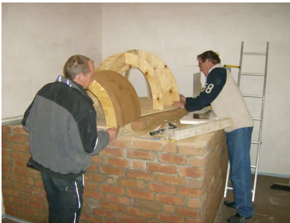
Achim fertigte die Schablone für das Gewölbe
