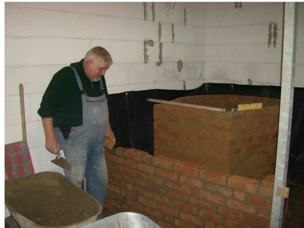
Die Außenschalung wird aufgemauert, der Zwischenraum wird mit Lehm gefüllt
